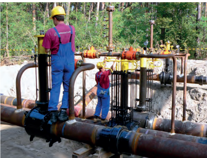
Montaż podziemnych kurku kulowych AG dla Nafta a.s., Słowacja
