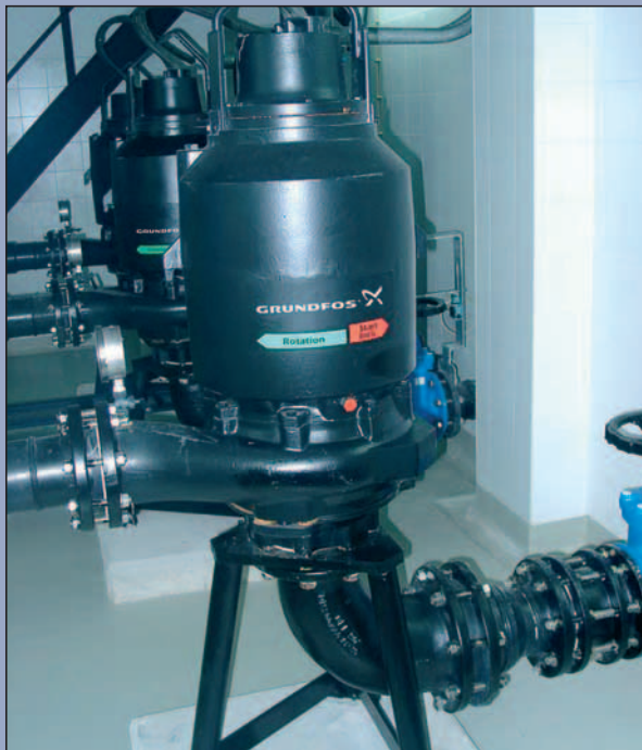
Przepompownia z 3 pompami ściekowymi - instalacja pionowa sucha.
